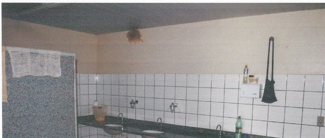
ILUSTRAÇÃO 46 – FORRO DE PVC NO VESTIÁRIO DOS JUÍZES
