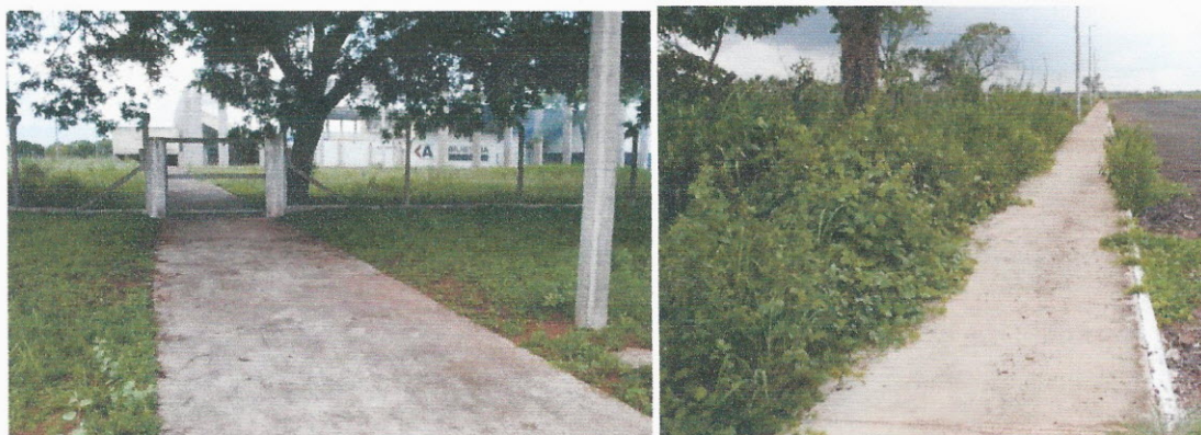
ILUSTRAÇÃO 25 – PASSEIOS DE CONCRETO
