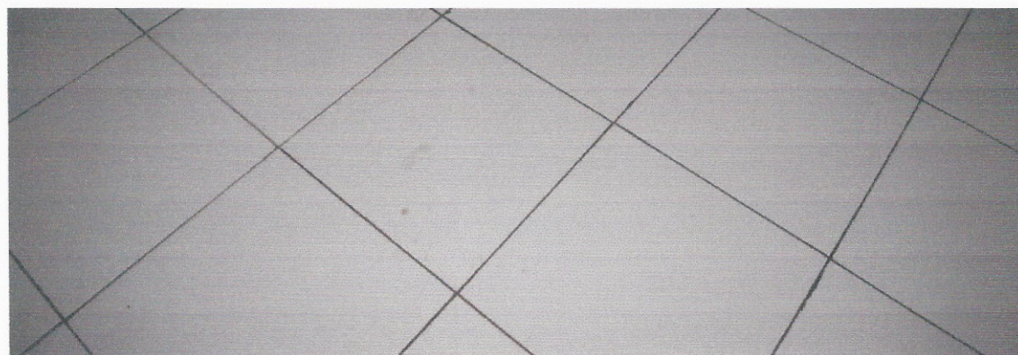
ILUSTRAÇÃO 38 – PISO CERÂMICO EXECUTADO
