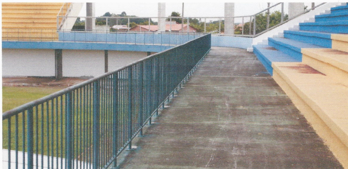
ILUSTRAÇÃO 50 – GUARDA-CORPO (AZUL) E ALAMBRADO AO FUNDO (CINZA)
