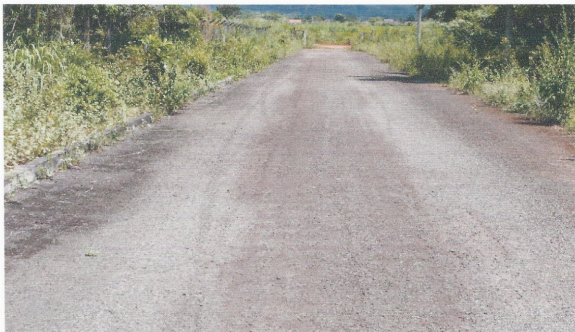
ILUSTRAÇÃO 21 – PISTA DE ACESSO AO ESTACIONAMENTO DOS FUNDOS
