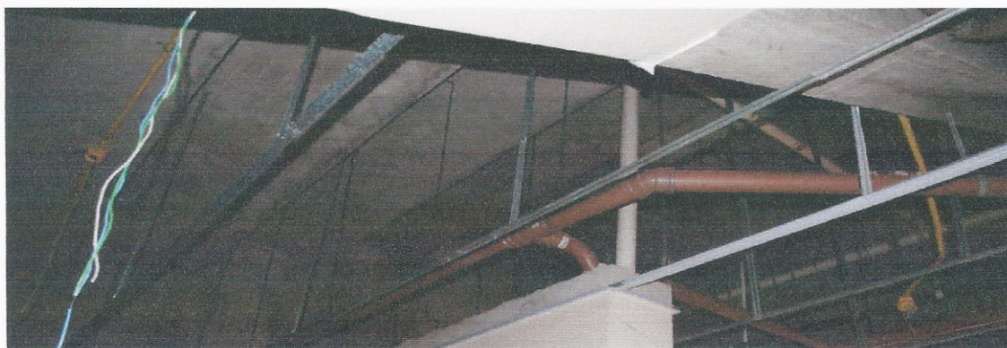
ILUSTRAÇÃO 47 – FORRO RETIRADO NOS SANITÁRIOS DA TORCIDA (REFORMA)
