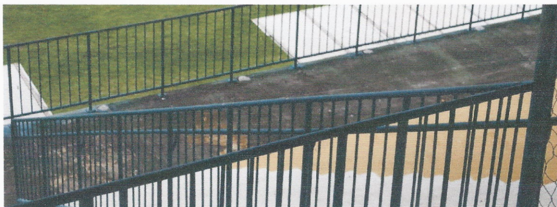
ILUSTRAÇÃO 51 – GUARDA-CORPOS PRESENTES NAS ARQUIBANCADAS DO ESTÁDIO
