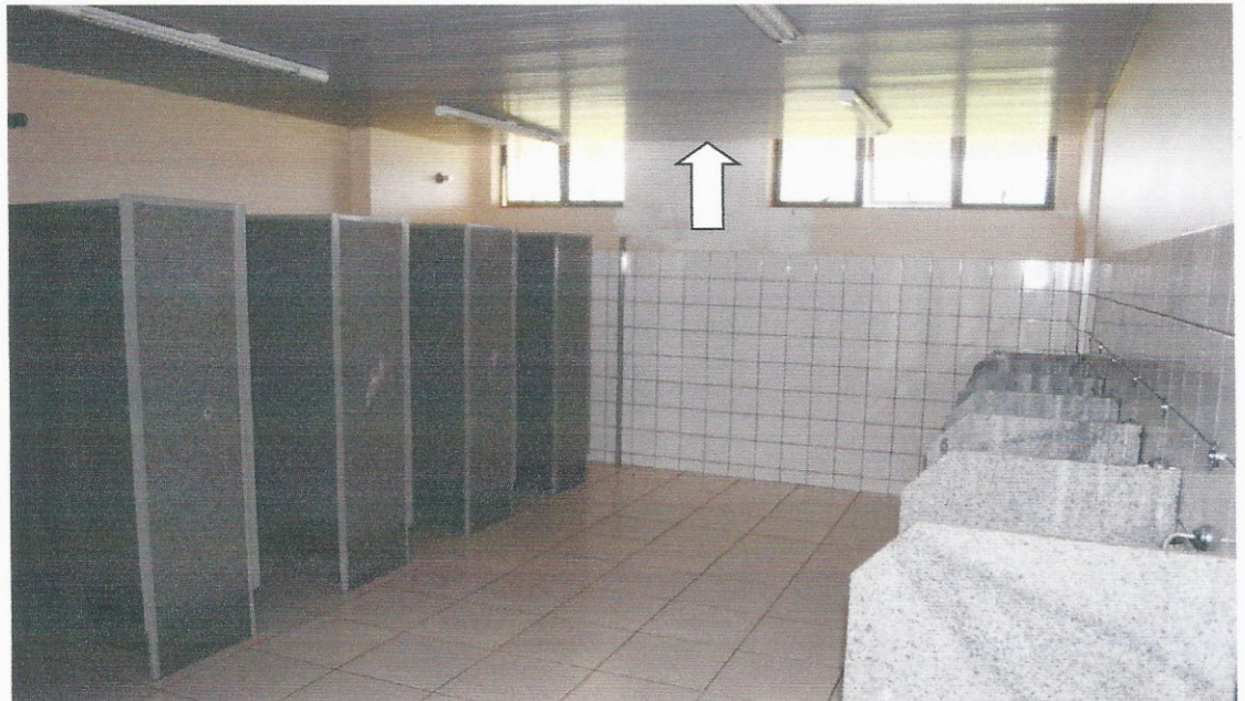
ILUSTRAÇÃO 44 – FORRO NOS BANHEIROS DOS VESTIÁRIOS
