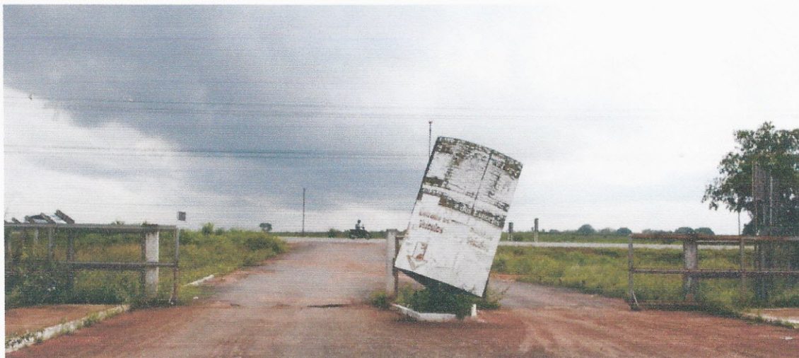
ILUSTRAÇÃO 31 – PORTÕES DE ENTRADA DE TUBO GALVANIZADO
